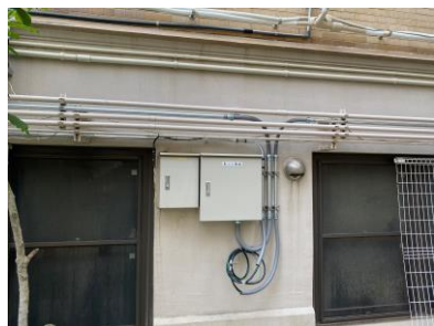
空調電源工事
