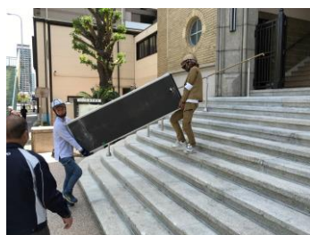
旧室内機撤去
