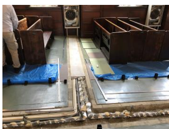
不要配管撤去
