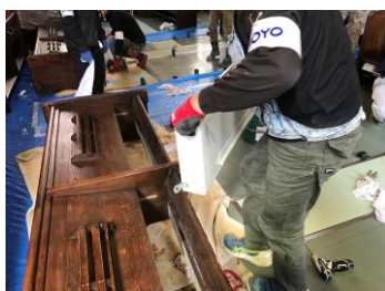
旧暖房機撤去
