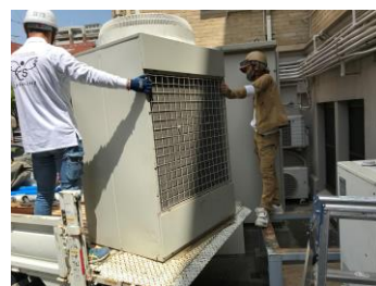
旧室外機撤去
