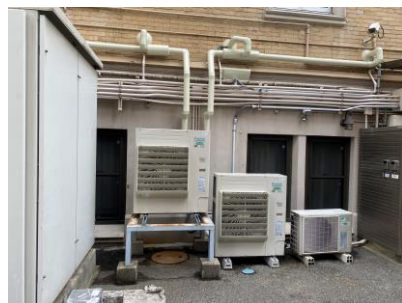
配管ラッキング仕上
